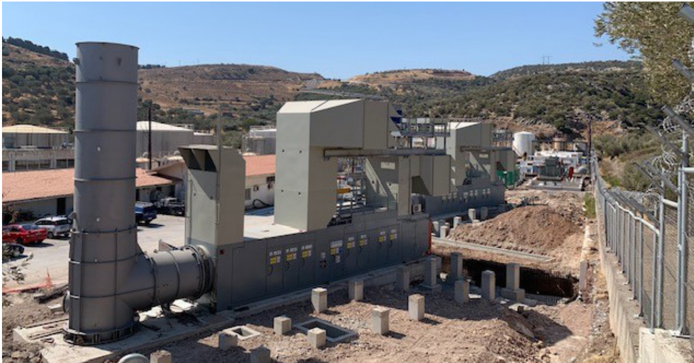
Σε πλήρη εξέλιξη η εγκατάσταση δύο νέων αεριοστροβιλικών μονάδων συνολικής ισχύος 29MW στη Λέσβο - αρχές του 2026 σε δοκιμαστική λειτουργία
